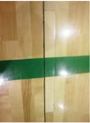
写真：普通張り工法 ノリ釘併用工法+水性ポリウレタンでの施工 捨て張り合板の長手に沿って隙間が発生している
