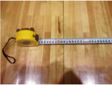
写真：普通張り工法 ノリ釘併用工法+水性ポリウレタンでの施工 捨て張り合板の長手に沿って隙間が発生している
